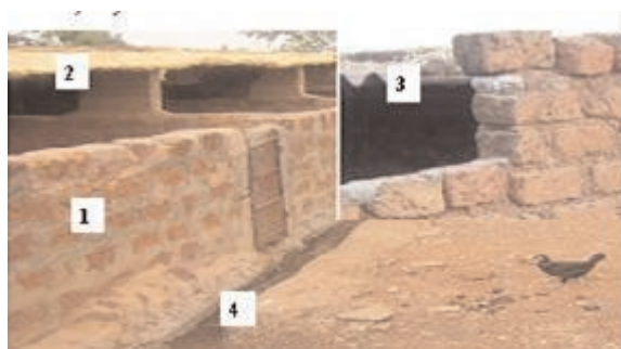
Figure 4 : Logement du type B en ouvertures (2 et 3) et canal à purin (4)
