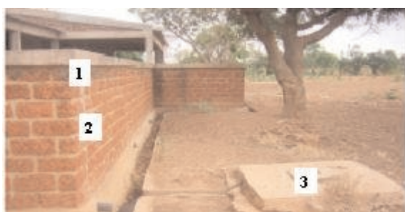
Figure 3 : Logement du type A en pierre taillée (2) Ouvertures (2) et canal à purin+fosse septique (3)
