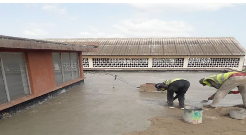
Photo 6 : Travaux pour l'étanchéité sur un bâtiment de l'annexe route de Rufisque
